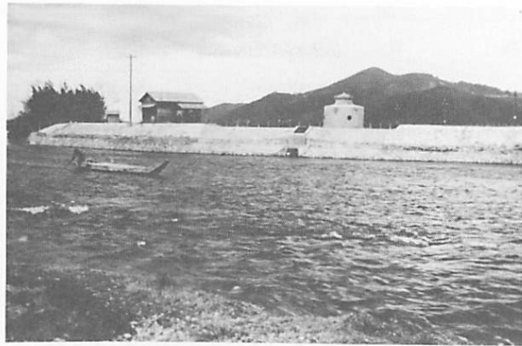
図13 中島上水道取水口（津山市水道局蔵）
